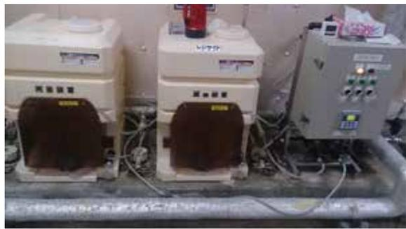
【導入施設の概要】現場で、アンモニア剤と塩素剤を反応させてモノクロラミンを生成。一回ごとに定量のモノクロラミンを投入し、濃度管理は投入間隔のタイマー制御による。高濃度配管洗浄もボタン一つで可能。
