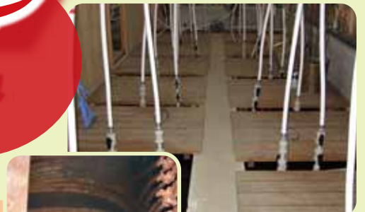
▲廃熱回収槽(13.5m×3.8m)
