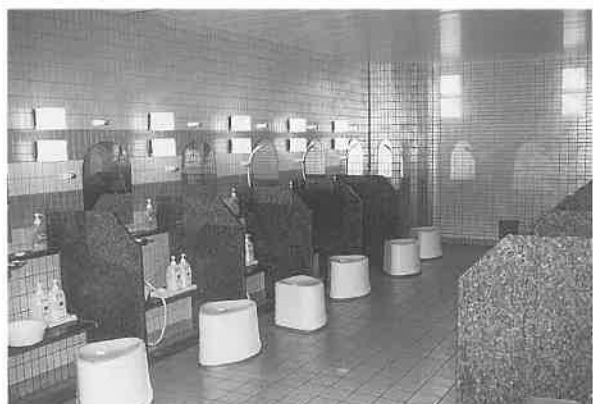
オールシャワー方式の洗い場
