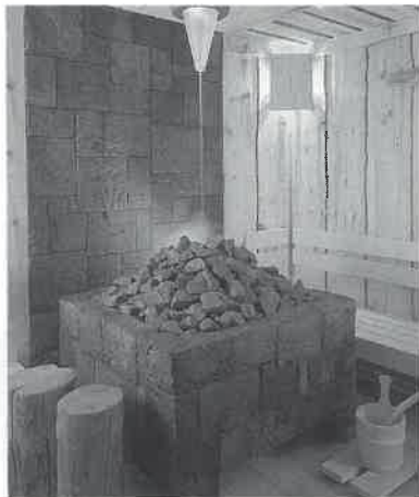
ストーブ上の照明から数分毎に水が落ちるウォータディスペンサー。
