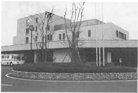
センター本館
