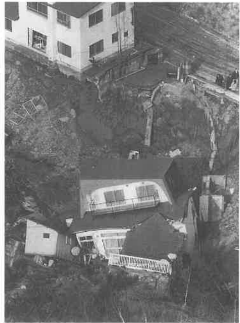
釧路沖地震でずり落ちた民家(釧路市緑ヶ岡)。共同通信社提供。
