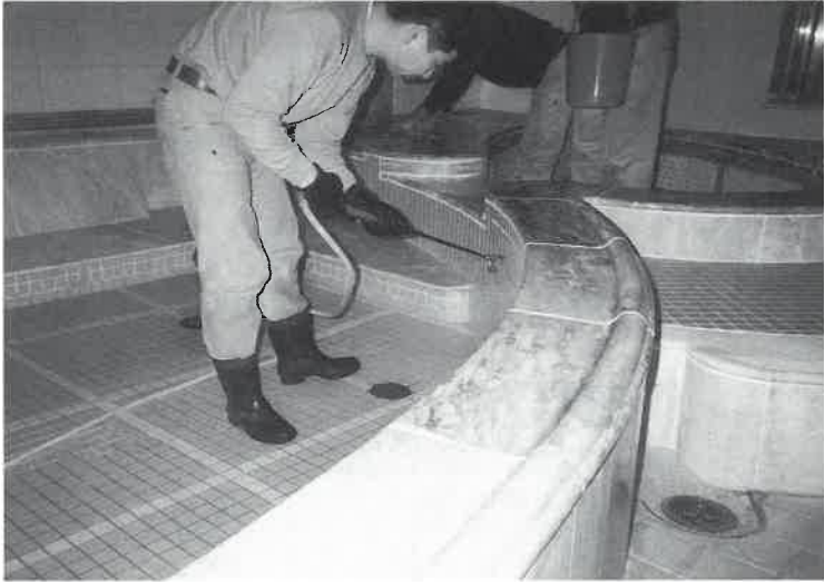
浴槽防水の作業が進む
