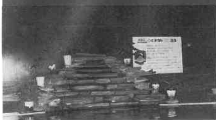
ジャクリンシステムの施工例
